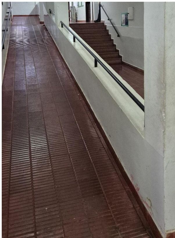
Figura 7: Rampas de acceso en la Universidad Católica. Nota. Imagen de Elaboración Propia.
