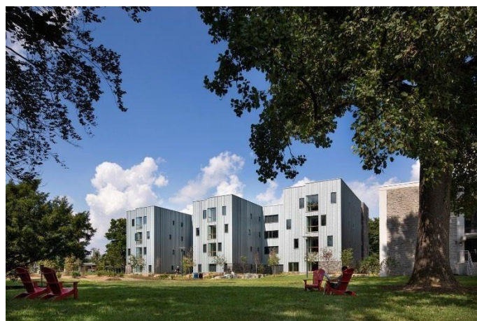
Figura 12. Patios Exteriores. Fuente (ArchDaily)
