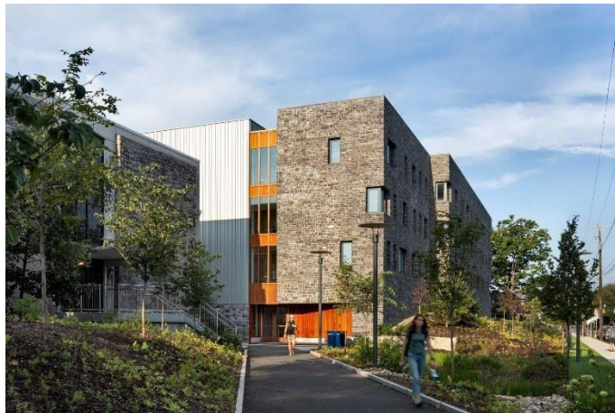
Figura 14. Entrada a la residencia. Fuente (ArchDaily)
