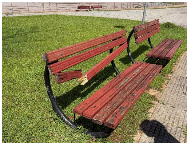
Imagen 6: Los asientos están dañados por degradación biológica de la madera debido a la absorción de humedad, combinada con deterioro estructural, todo agravado por la falta de mantenimiento. Nota: Imagen de elaboración propia
