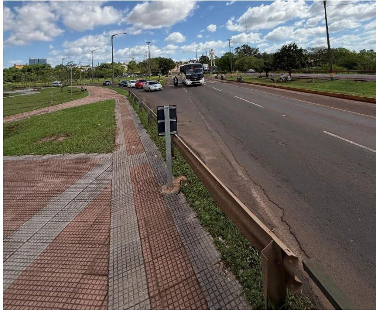
Imagen 7: Trayectorias de acceso, salida deficientes y problemas de seguridad para peatones. Nota: Imagen de elaboración propia
