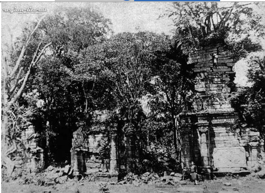
Figura 1. Vista del frente de la Iglesia de la Misión Jesuítica de San Ignacio Misiones Argentina, cubierta por árboles y en estado avanzado de destrucción. Ca. 1940. Fuente: Archivos del autor.
